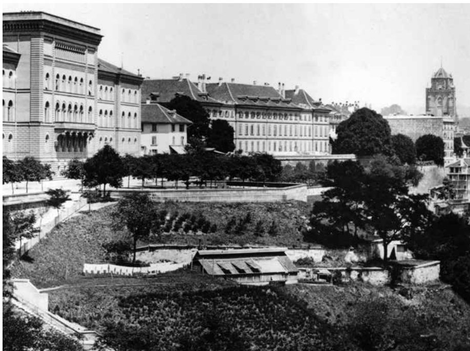
Altes Inselhospital um 1880 (rechts im Bild). Vorne links ist der Westflügel des Bundeshauses und gleich anschliessend das alte Casino zu sehen.
