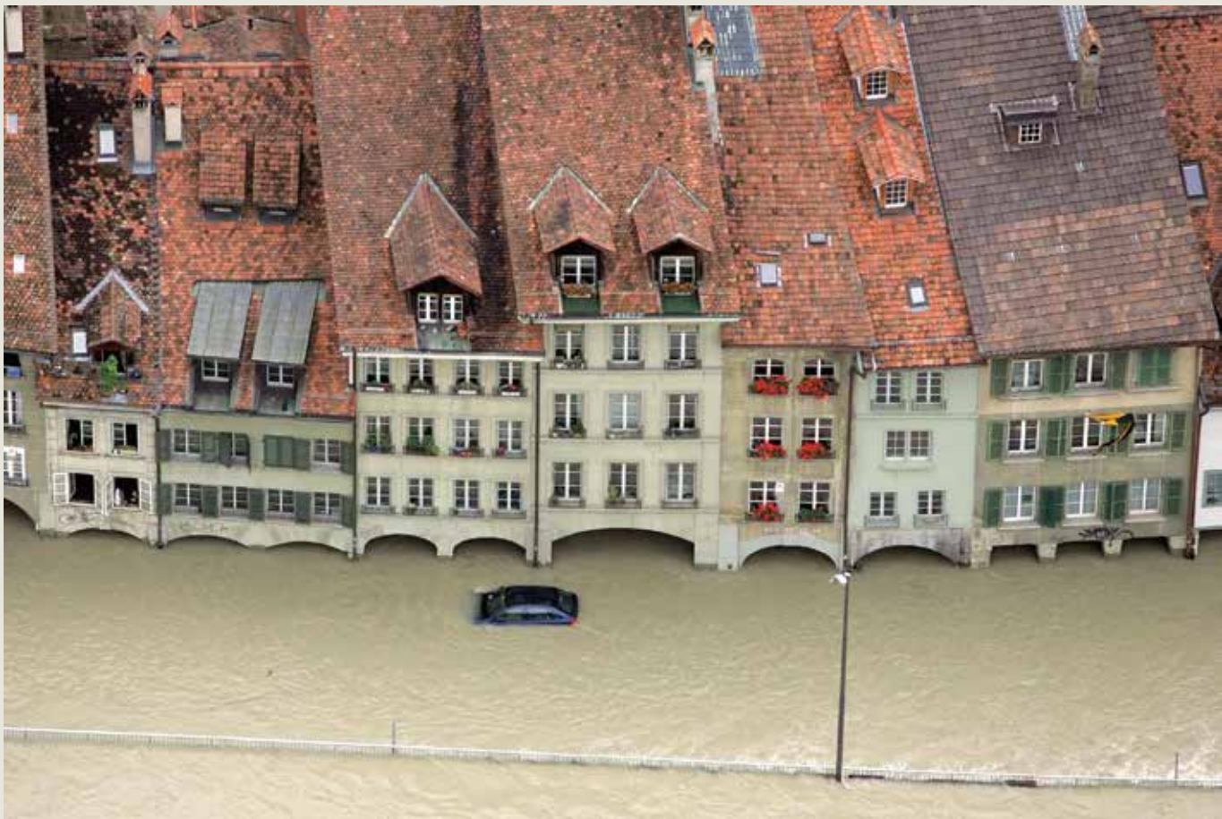
Wenn «Jahrhunderthochwasser» – hier am 23. August 2005 im Berner Mattequartier – im Klima der Zukunft alle zehn Jahre vorkommen, zahlen auch die Versicherungen öfter.
