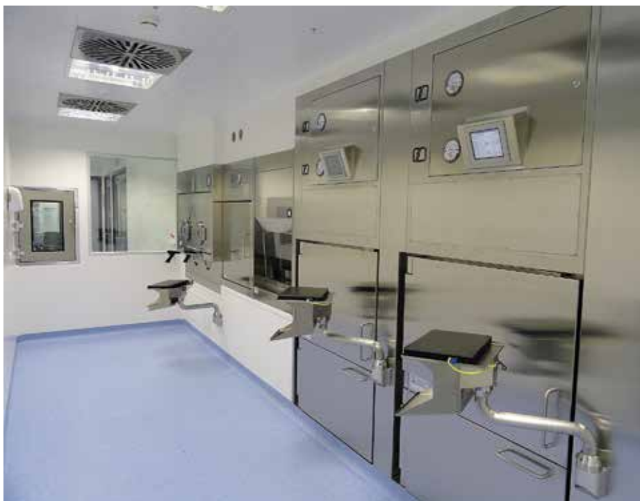
Blick in ein Reinraum-Labor mit höchster Zertifizierung. Die Hotzellen sind mit Blei abgeschirmt, im Innern herrscht Unterdruck.
