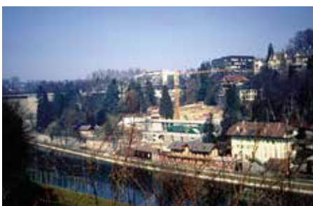
Baustelle für die neuen Schauhäuser 1975.
