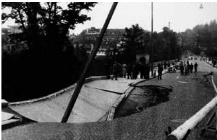
Einsturz der Lorrainebrücke-Strasse nach dem Institutsneubau 1948.
