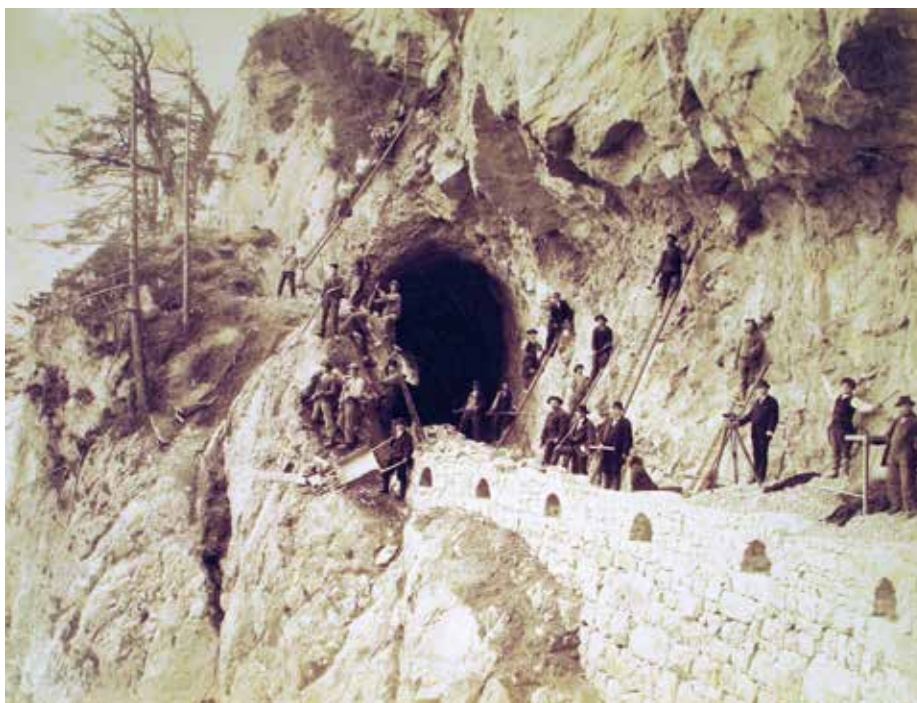
Strassenarbeiter und Ingenieure beim Bau der Strasse Merligen–Neuhaus entlang des Thunersees 1882–1884.
